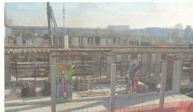
La costruzione dell'edificio che ospiterà la comunità alloggio
